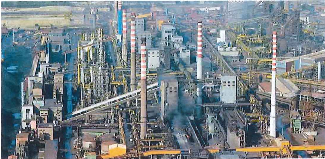
L'IMPIANTO SIDERURGICO PIÙ GRANDE D'EUROPA La visuale sull'Ilva presa dai tetti dei palazzi del vicino rione «Tamburi»
